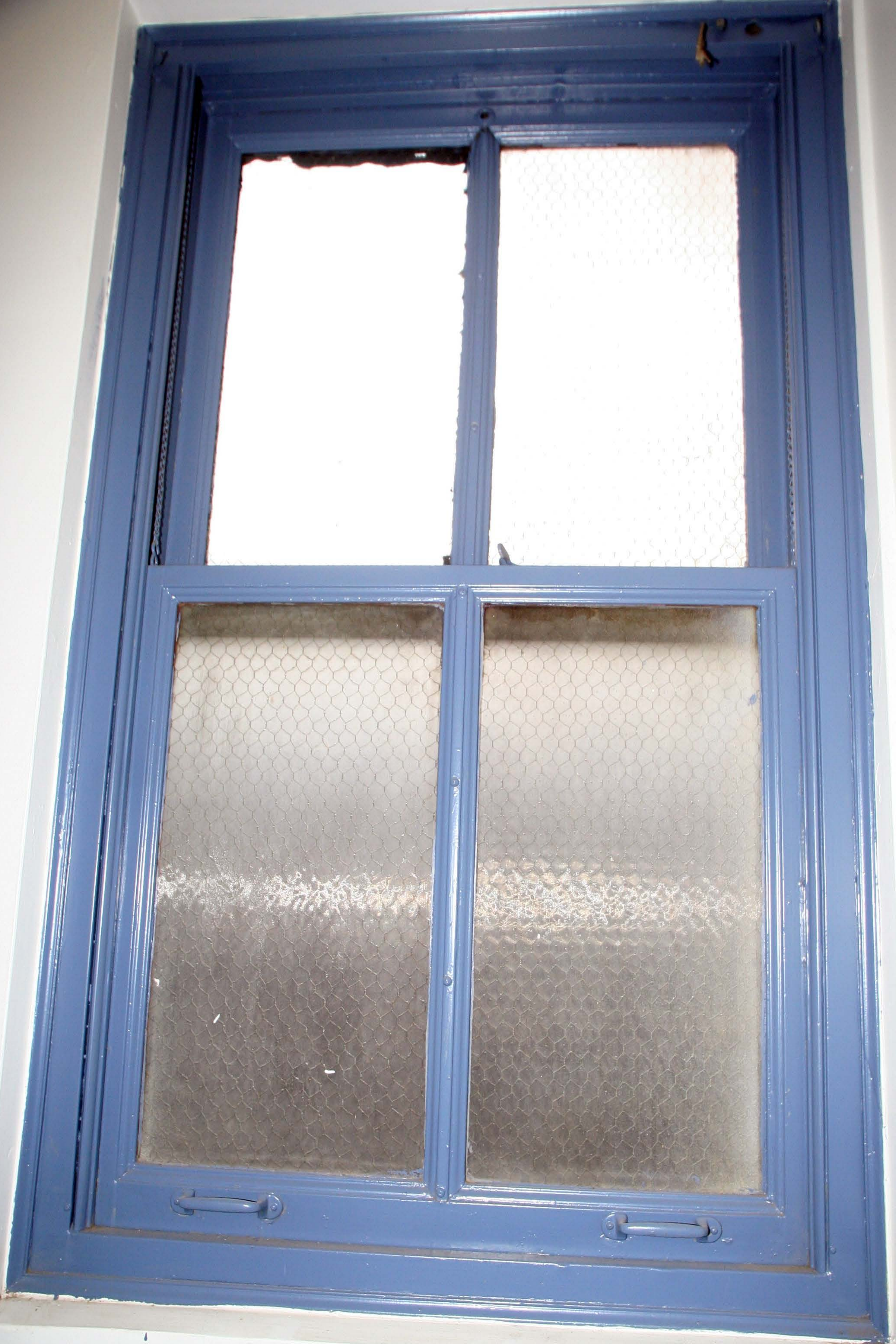
N. EAST STAIR ROOF ACCESS
